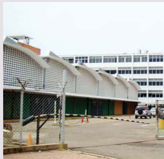
En los trabajos de rescate de la infraestructura se estructura original
