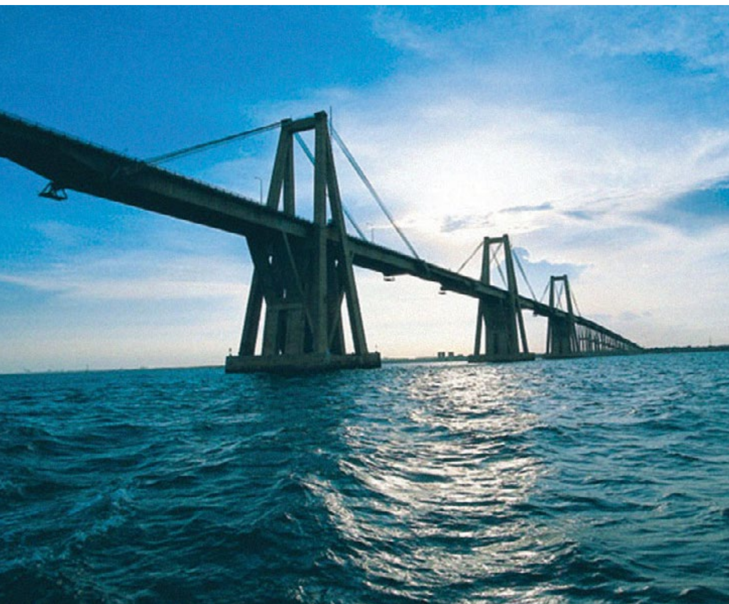
Puente sobre el Lago de Maracaibo - General Rafael Urdaneta
